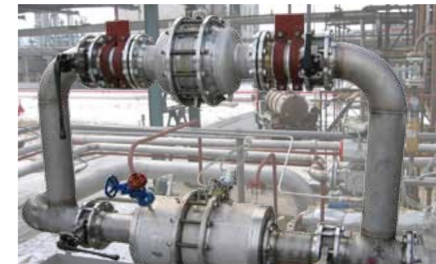
Применения на диметилтерефталате: Клапаны и огнепреградители с рубашками обогрева
